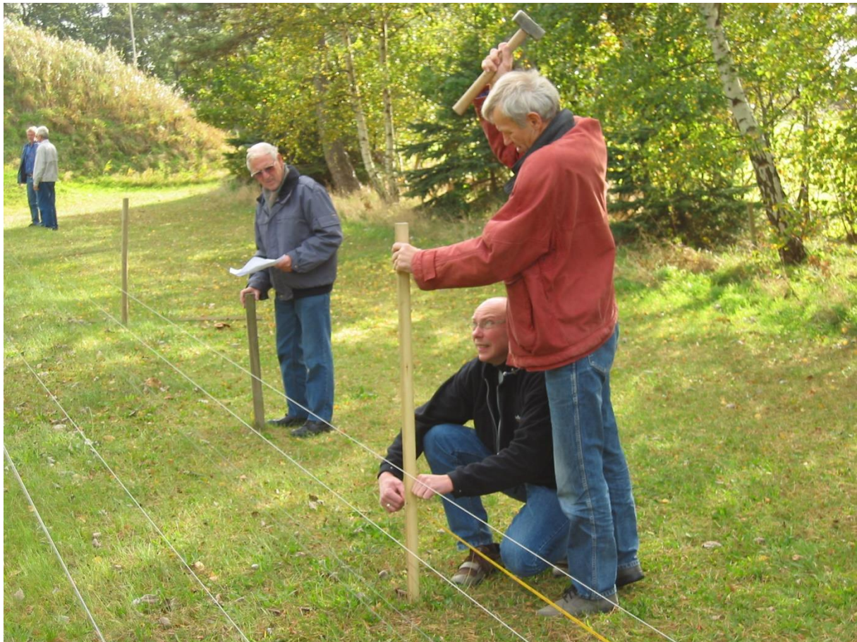
11-10-2003: Opmåling og markering til afgravning af baneplan og opsætning af rikochetværn.
