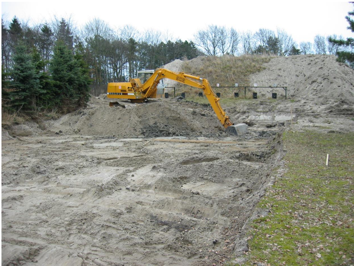
24-03-2004: Den afgravede jord trækkes ned til udvidelse og forhøjelse af skydevolden.
